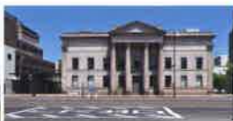
ルネスホール(旧日銀岡山支店) 1922年 日銀岡山支店 設計：長野宇平治 2005年 ルネスホール 設計：佐藤 正平
