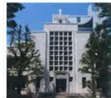
ノートルダムホール東棟 (1929年) 設計：アトキンソン
