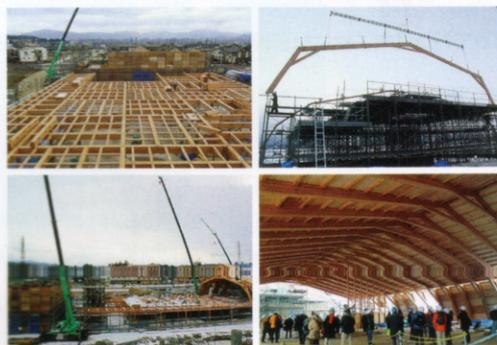
2011年9月着工。1階部分架構完成の後、この上に床を張ってプラットフォームをつくり、その上で2階のフレームを治具に合わせて組み立てクレーンで吊り上げ定位置に固定した。2012年5月竣工。\*\*
